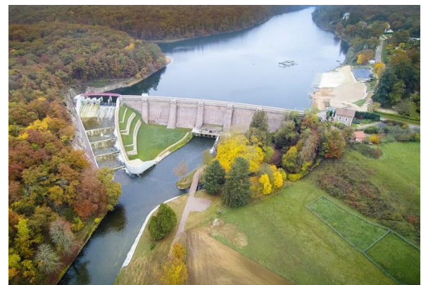
Pont-et-Massène Dam @VNF
