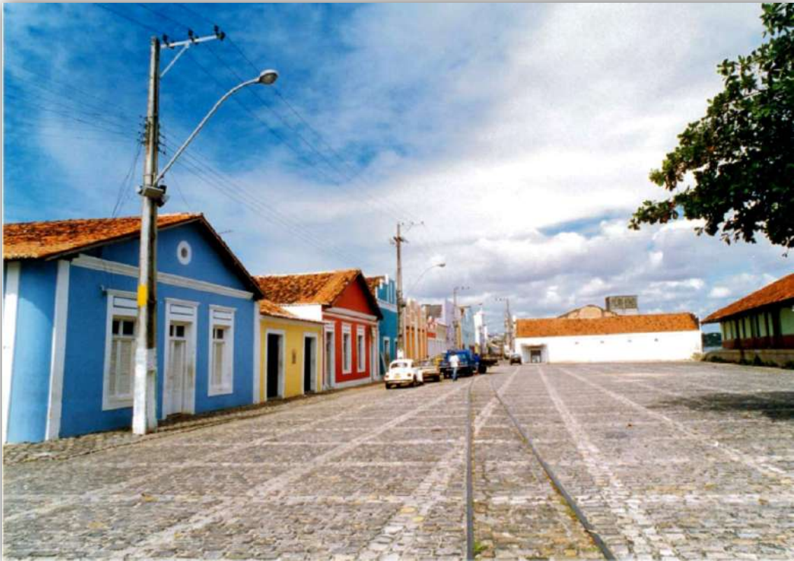
FIGURA 29: Largo da Rua Chile (b). Fonte: Projeto ReHabitatar em Natal. SEMURB, 2008. p.36.
