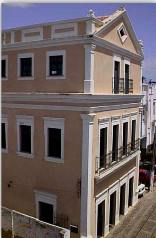
FIGURA 24: O grande sobrado da Rua Chile pós-restauração.
