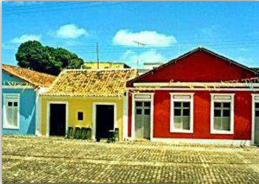
FIGURA 20: Casas reformadas no Largo da Rua Chile – fins dos anos 1990.
