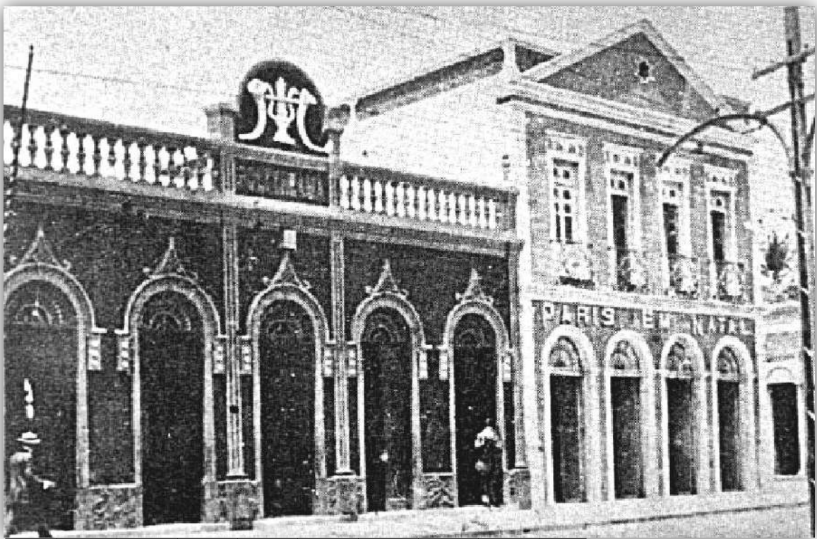
Figura 9: Fachadas do cinema Polytheama e da loja Paris em Natal. Fonte: Secretaria Municipal de Meio Ambiente e Urbanismo (SEMURB).
