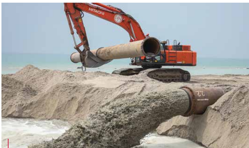
Aan land geperst zand wordt gecontroleerd verspreid over de extra aan te leggen zone.
