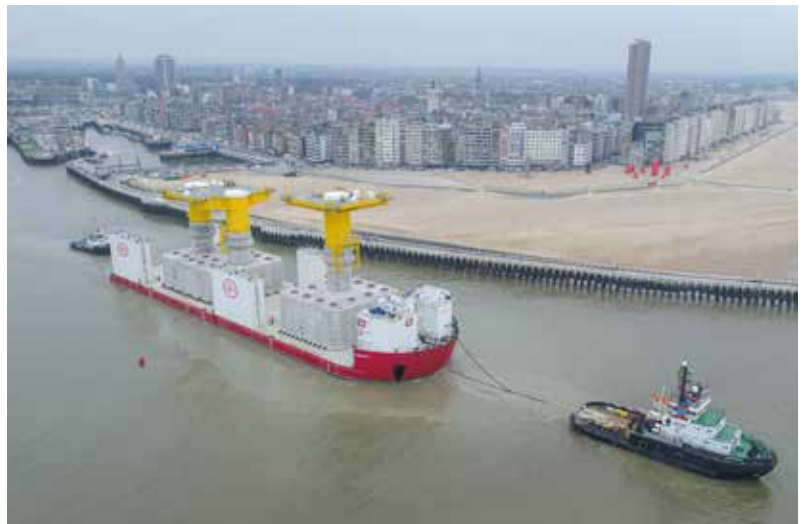
Voor het windmolenpark Kriegers Flak in Denemarken ontwierp en bouwde Jan De Nul Group de betonnen funderingen voor de offshore elektrische substations, op een drijvend ponton. We stonden ook in voor het transport en de effectieve installatie.
