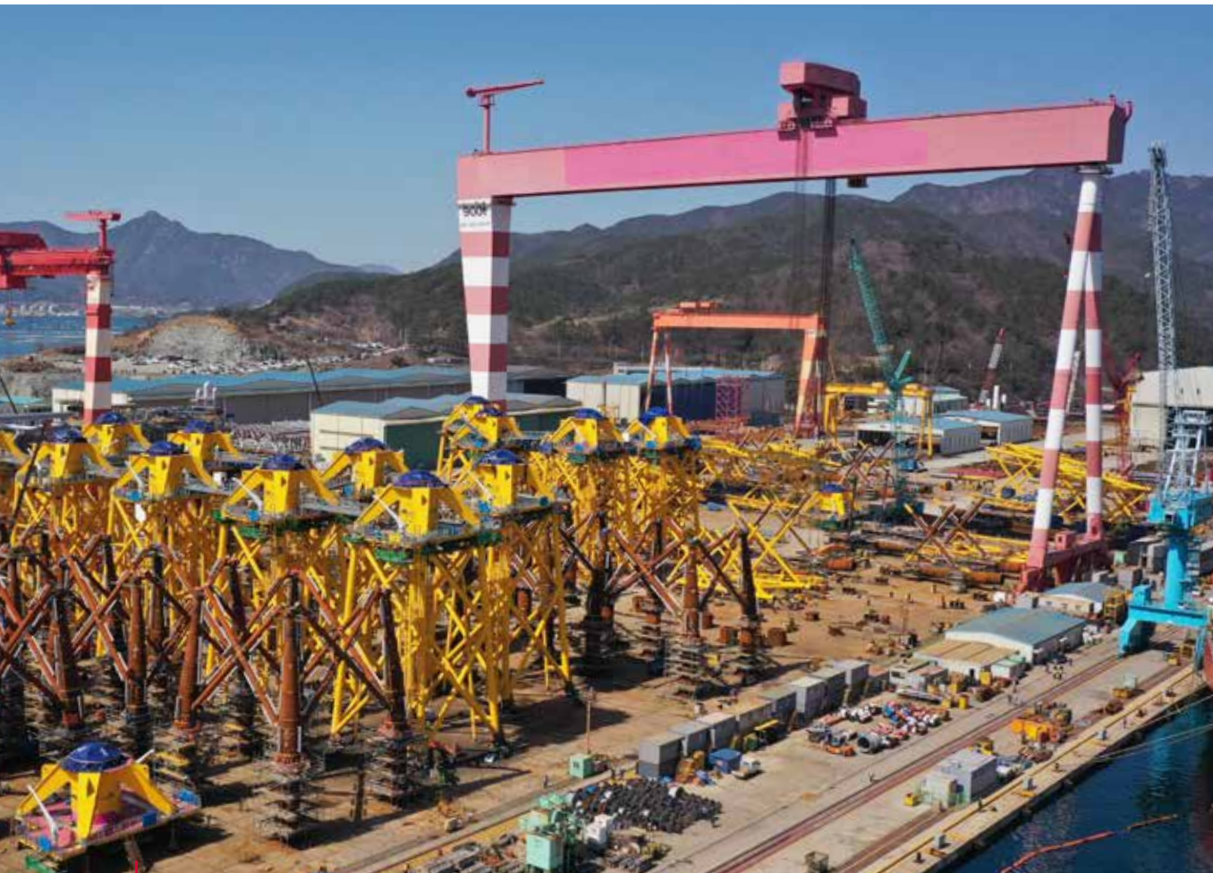
Jan De Nul Group stond in voor de bouw van het windmolenpark Taiwan Power Company Offshore Windfarm Phase 1 Project - Demonstration in Changhua. Van het ontwerp over de fabricage van de funderingen en het transport ervan, tot de installatie van de funderingen, de onshore en inter-array plus exportkabels, het onshore substation en de windturbines.
