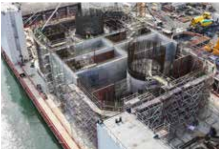
Voor het windmolenpark Kriegers Flak in Denemarken ontwierp en bouwde Jan De Nul Group de betonnen funderingen voor de offshore elektrische substations, op een drijvend ponton. We stonden ook in voor het transport en de effectieve installatie.
