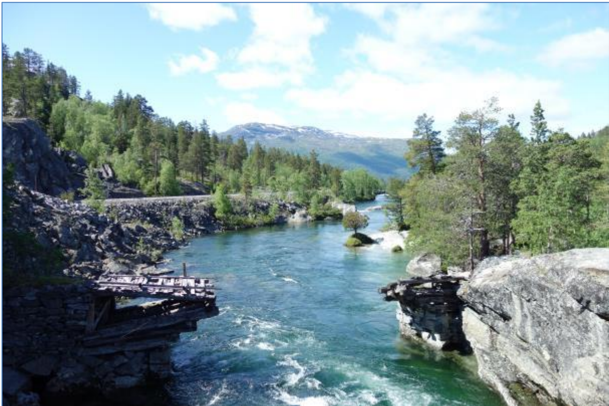
Figur 4. Restar etter utleggsbrua over Rauma, ved Sjøheimberget. (Foto: Lesja kommune)
