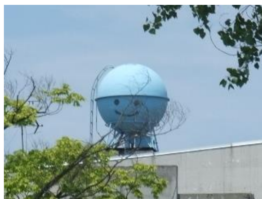
「サンピア」の屋上にある貯水槽
