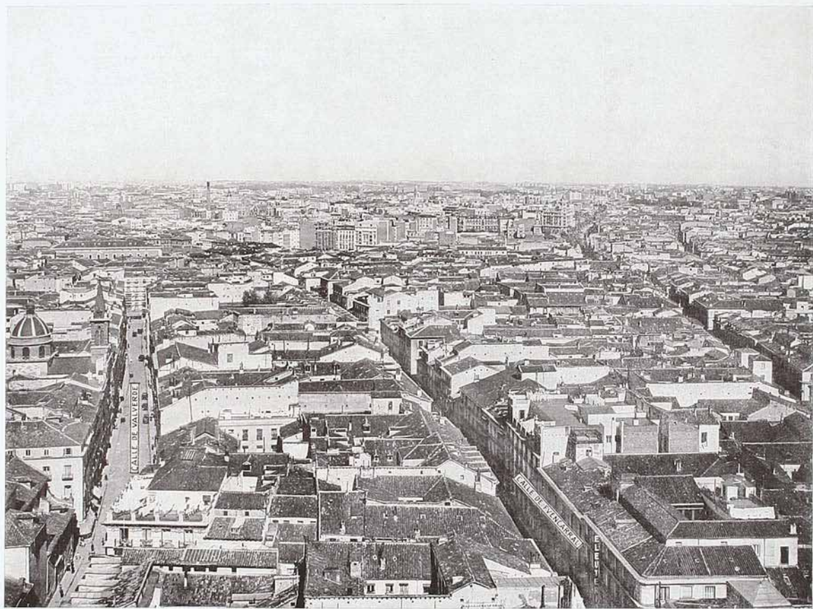
Vista panorámica obtenida desde el edificio de la Compañía Telefónica Nacional de España
