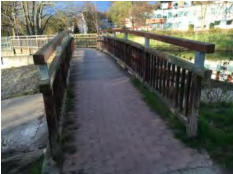
Abb. 3.4-5: Beispiel einer nachträglichen Erhöhung der Geländerhöhe einer Fuß- und Radwegebrücke<sup>41</sup>
