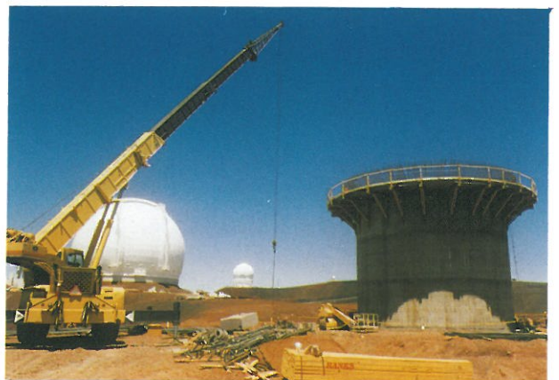
図1 マウナケア山頂での基礎工事の状況。望遠鏡を据え付けるコンクリートピアが立ち上がったところ。
