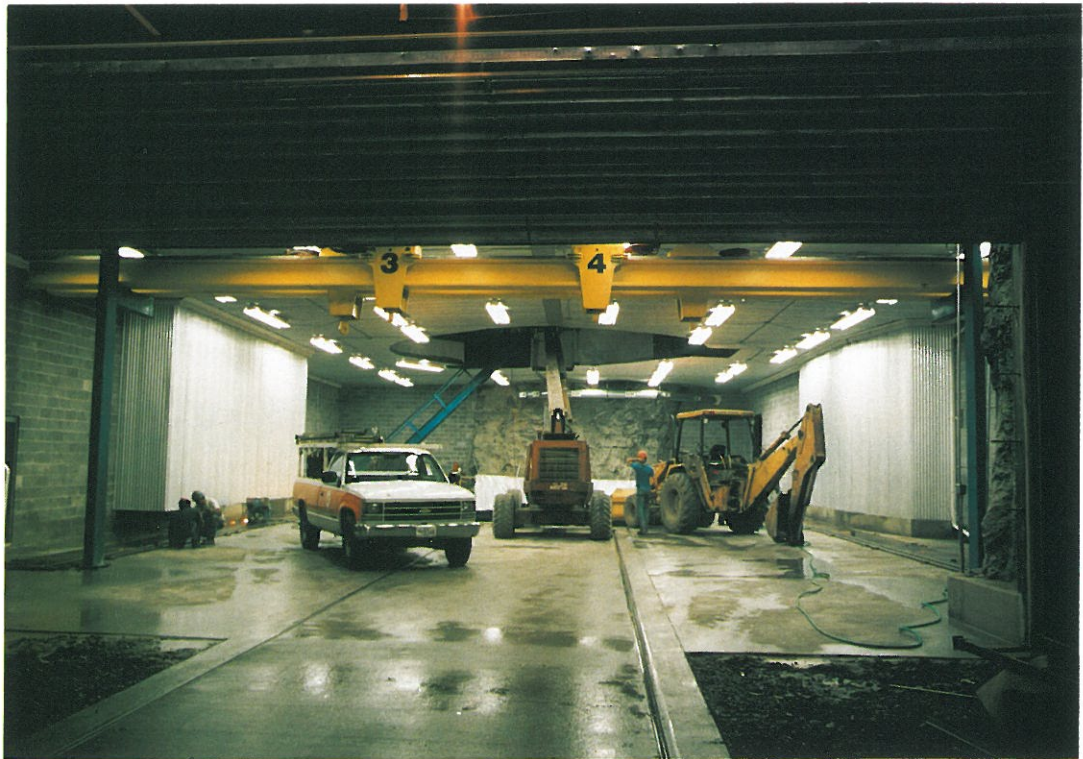
図2 内装工事が進むワンパンの地下研磨工場（コントラベス社）。
