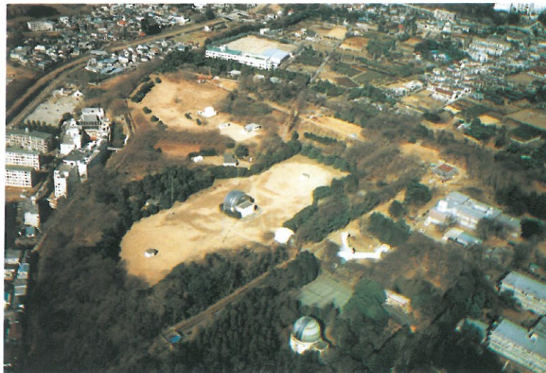
図1 TAMA300用重力波実験棟。建設中の航空写真。
