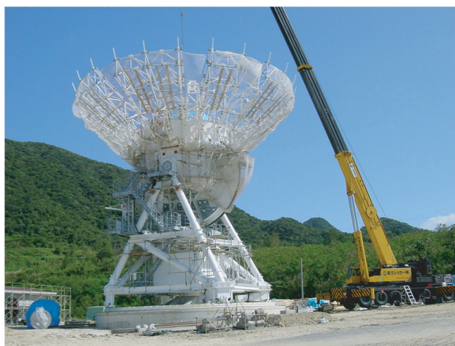
図1. 左：大型200tクレーンで組上げられる20m望遠鏡(2001年秋)、右：開局記念行事の施設公開で、動く電波望遠鏡を見上げる見学者
