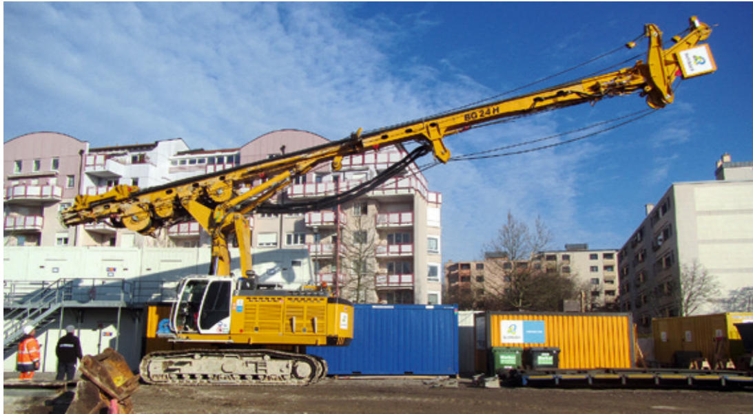
Mit dem Spezialgerät werden Träger für den Baugrubenverbau installiert.
