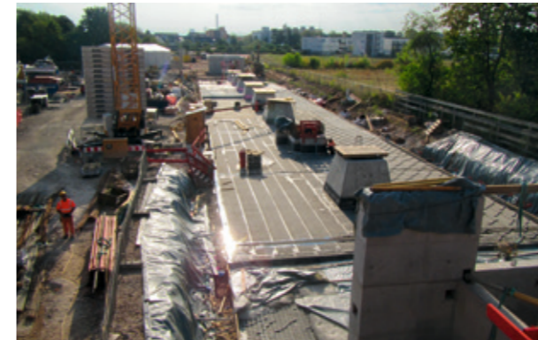
Abdichtung der Bauwerksdecken.
