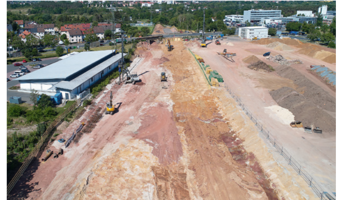
Baufeldfreimachung des künftigen Bahnhofs Gebersdorf (hinter Discounter).
