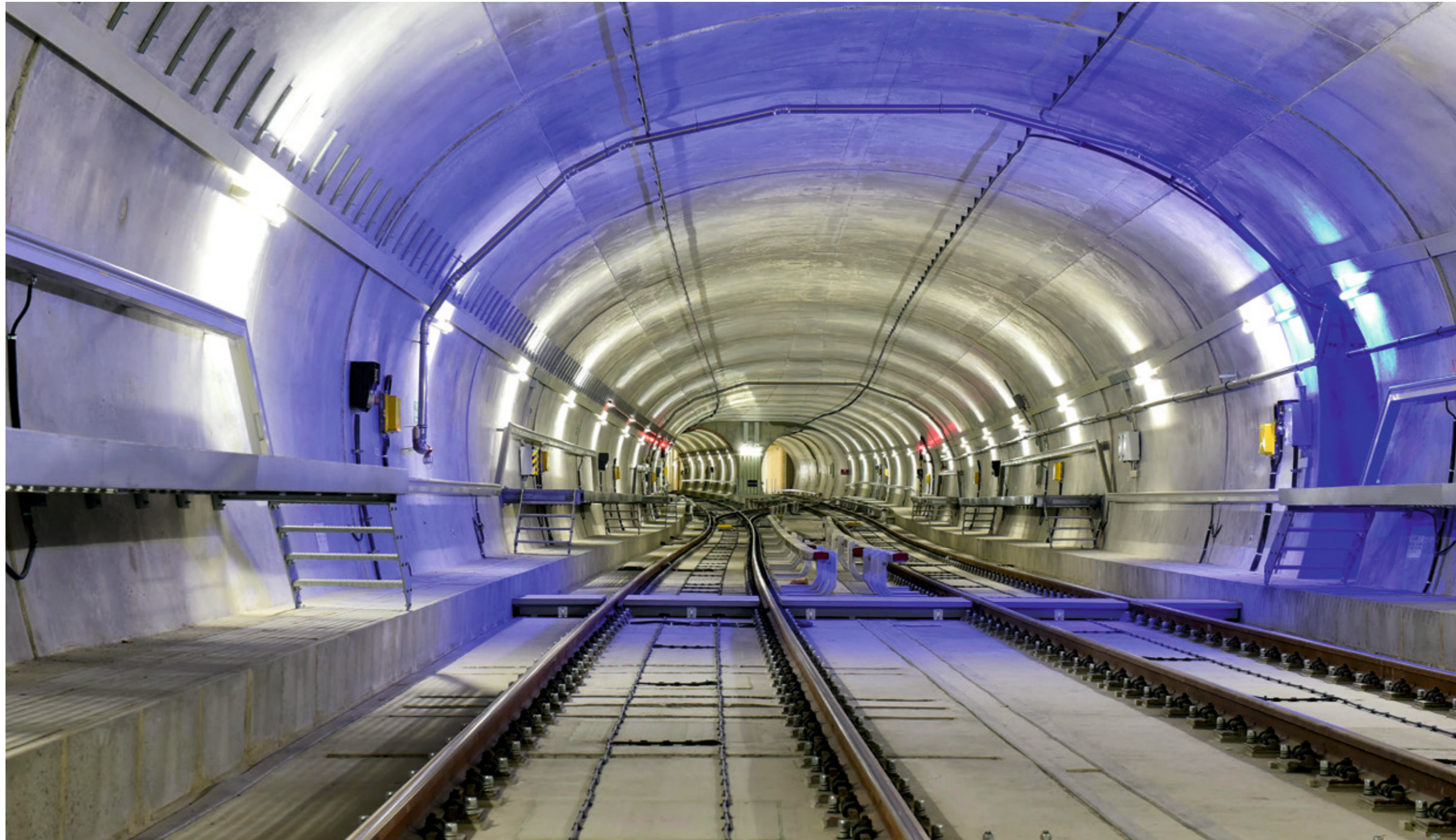
Die Tunnelröhre – blau beleuchtet ist der Weg zum Notausstieg.
