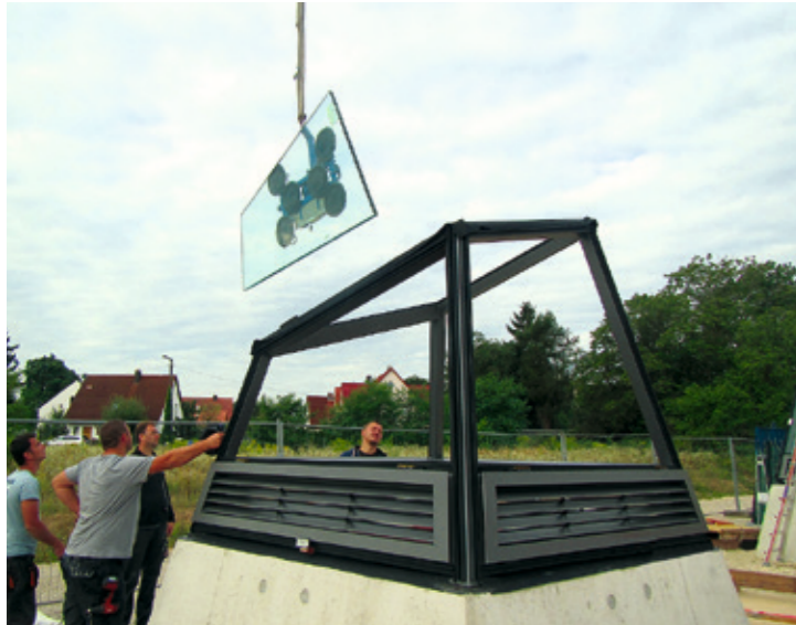
Für die Lichtkuppeln werden Glaselemente eingebaut.
