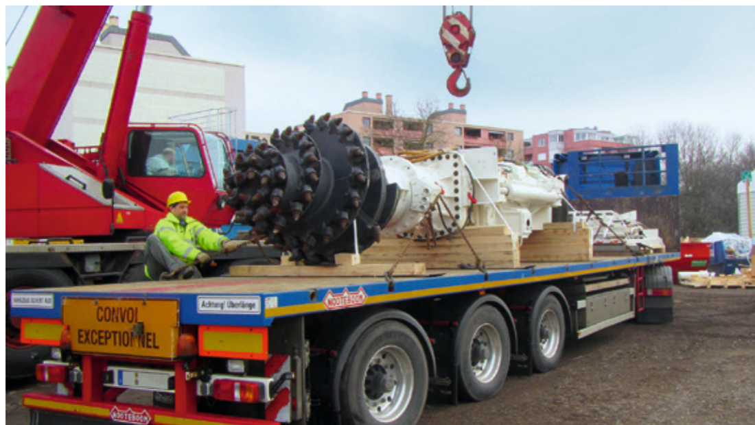
Der Fräskopf für den Tunnelvortrieb wird angeliefert.
