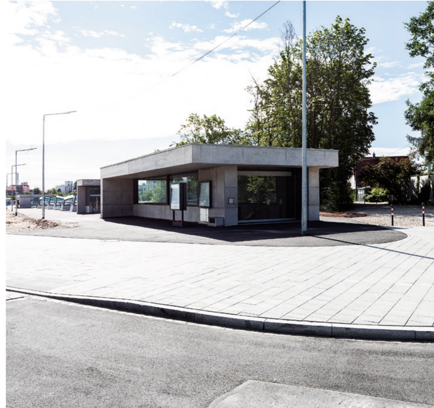
Zugang zu dem neuen U-Bahnhof Großreuth bei Schweinau.
