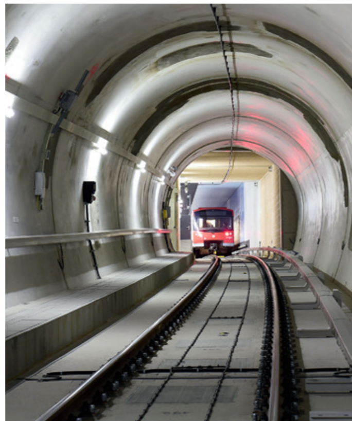
Je nach Fahrtrichtung geht es „bergauf“ oder „bergab“. Die Steigung bzw. das Gefälle kurz vor dem Bahnhof wirkt bremsend oder beschleunigend auf den U-Bahn-Zug. In beiden Fällen dient es der Minderung des Energieverbrauchs.
