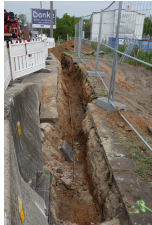
Spartenverlegung in Gebersdorf.
