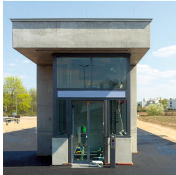
Behindertengerechter Aufzug kurz vor der Fertigstellung.
