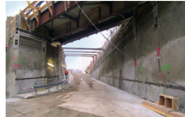
Rampe zur Hauptbaugrube.
