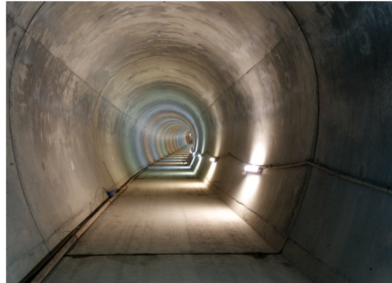
Ansicht des eingleisigen Tunnels.
