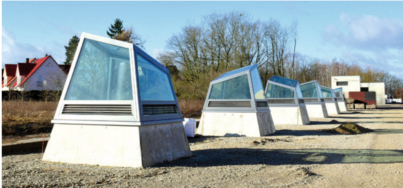
Die Lichtkuppeln am neuen U-Bahnhof im Endausbau.
