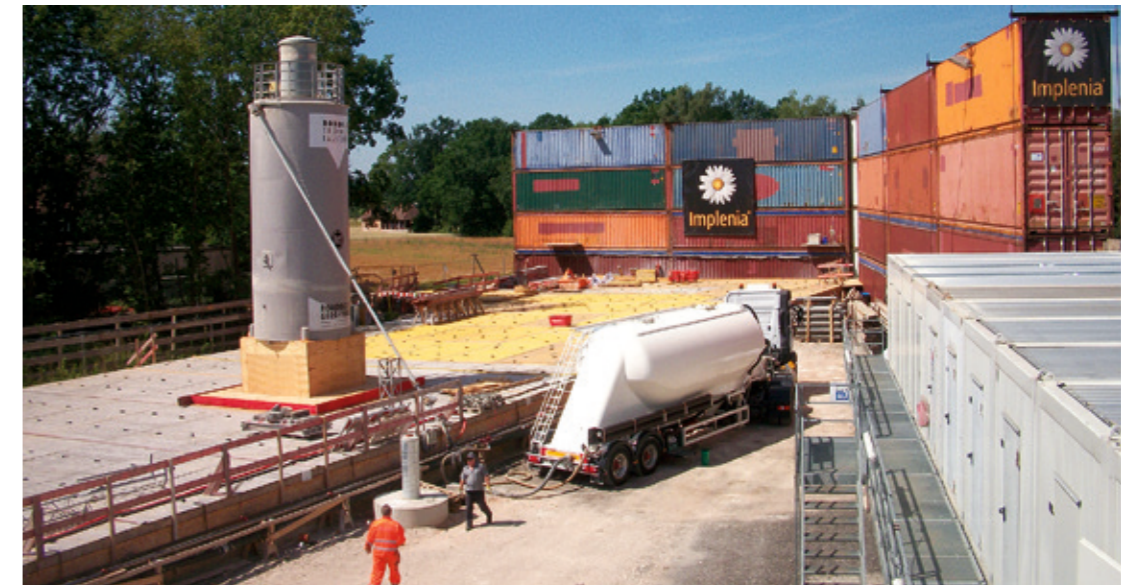
Alles für den Lärmschutz: Mit einer Schutzwand und Lärmmonitoring sollten die Belastungen so gering wie möglich bleiben.
