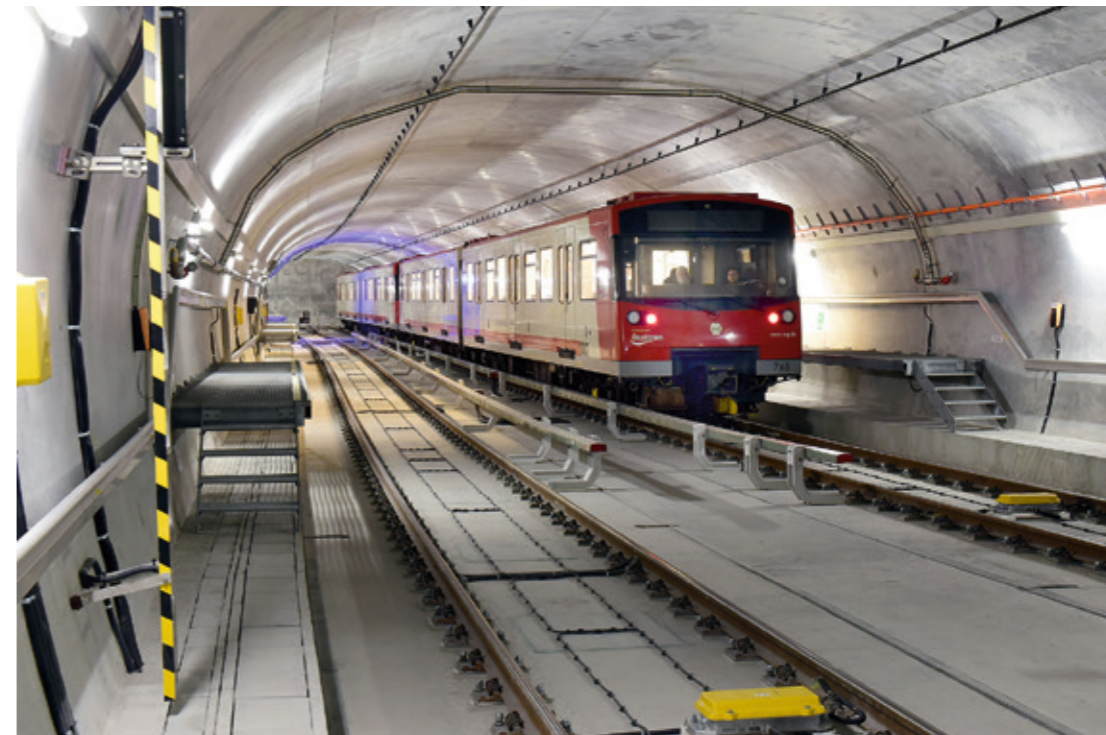
Die gesamte Tunnelröhre inklusive des Fahrwegs und der Bedienstege sind aus Beton. Das blaue Licht weist den Weg über den Notausgang nach oben. Nur für den Notfall.
