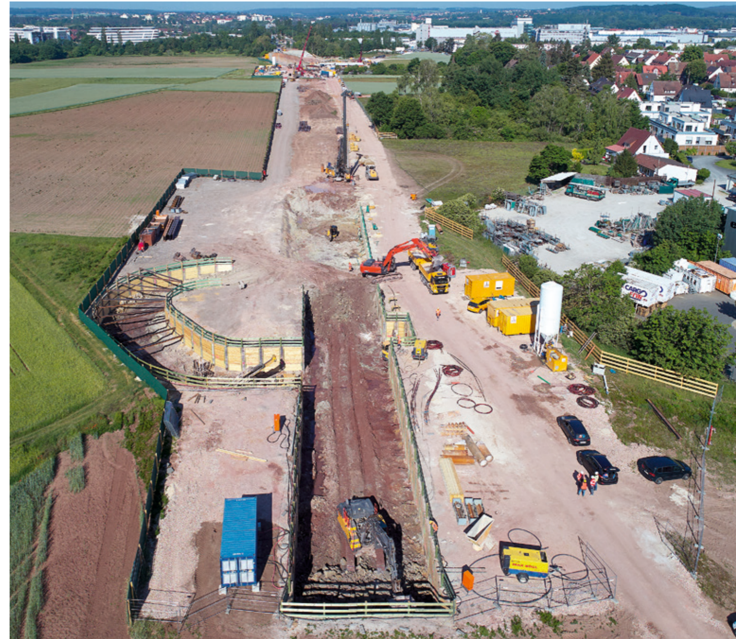
Baufeld in Richtung künftiger Bahnhof Kleinreuth.
