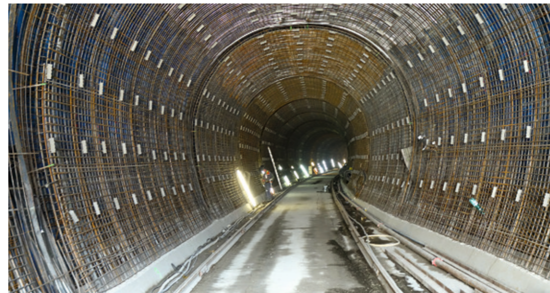
Bewehrungseinbau Innenschale im Gewölbe.
