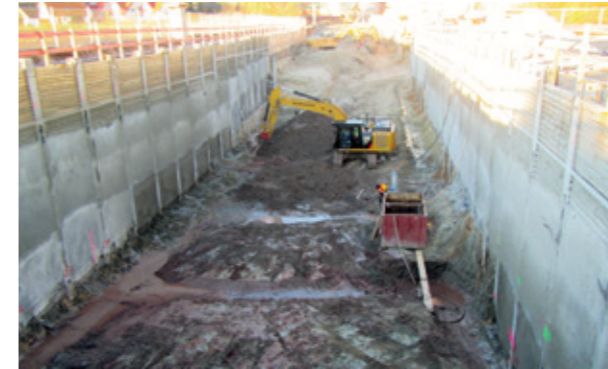
Aushub der Hauptbaugrube.
