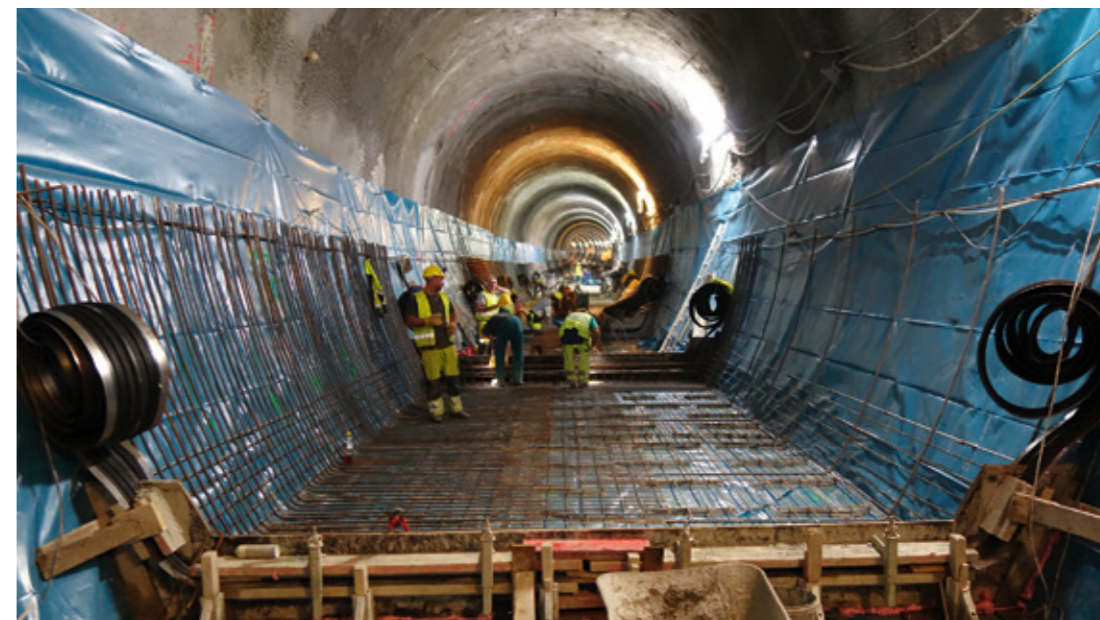
Bewehrungseinbau Innenschale in der Sohle.
