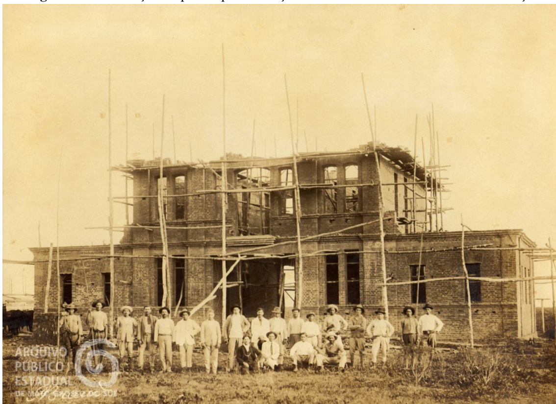
Figura 5 – Construção do prédio para a Força Pública Estadual em Ponta Porã e situação atual
