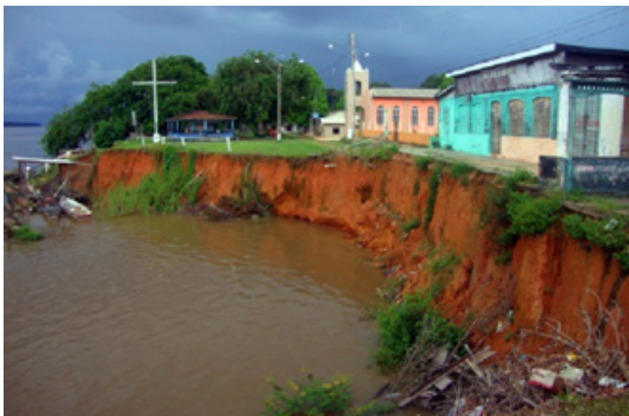
Distrito de Calama-RO sendo devastado pelo desbarrancamento (Fonte: MARINHA DO BRASIL)
