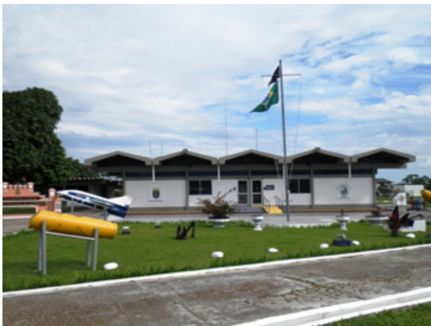
Vista das instalações atuais da CFT (Fonte: MARINHA DO BRASIL)
