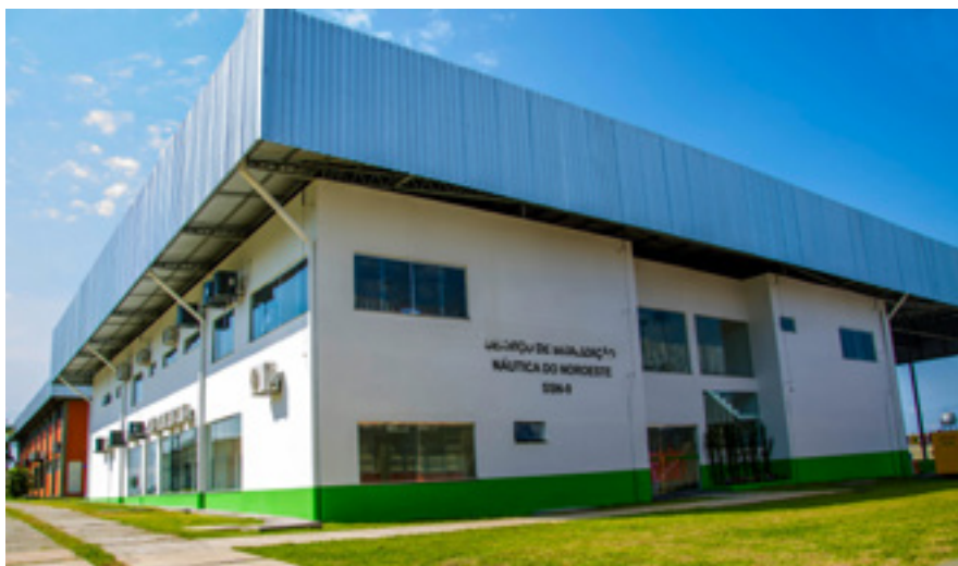
Prédio do Serviço de Sinalização Náutica do Noroeste (SSN-9) (Fonte: MARINHA DO BRASIL)
