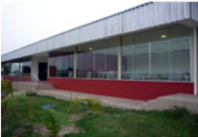
Visão frontal do refeitório
