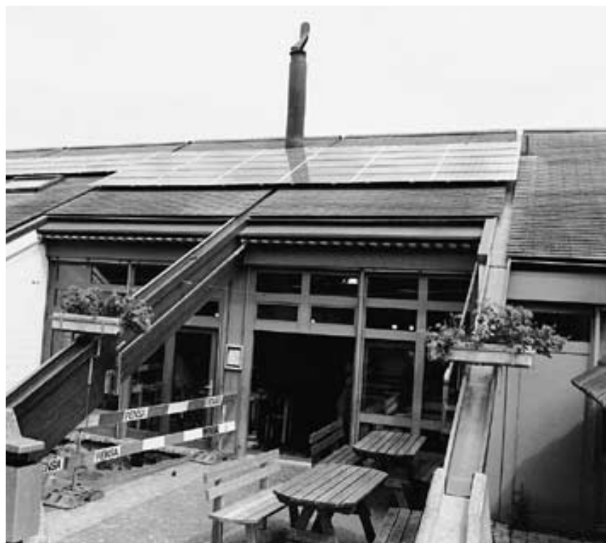
Die 1998 auf dem Dach des Freizeitentrums Landauer installierte Photovoltaikanlage (Bild) ist nur eines von zahlreichen Projekten, für die die Gemeinde Riehen nun mit dem ersten «Faktor-4-Preis» ausgezeichnet wurde. Foto: RZ-Archiv
