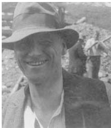
chantier SCI de Feldis en 1927
