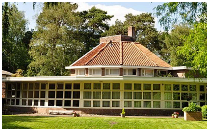
De Werkplaats , bâtiment original de 1927-1929
