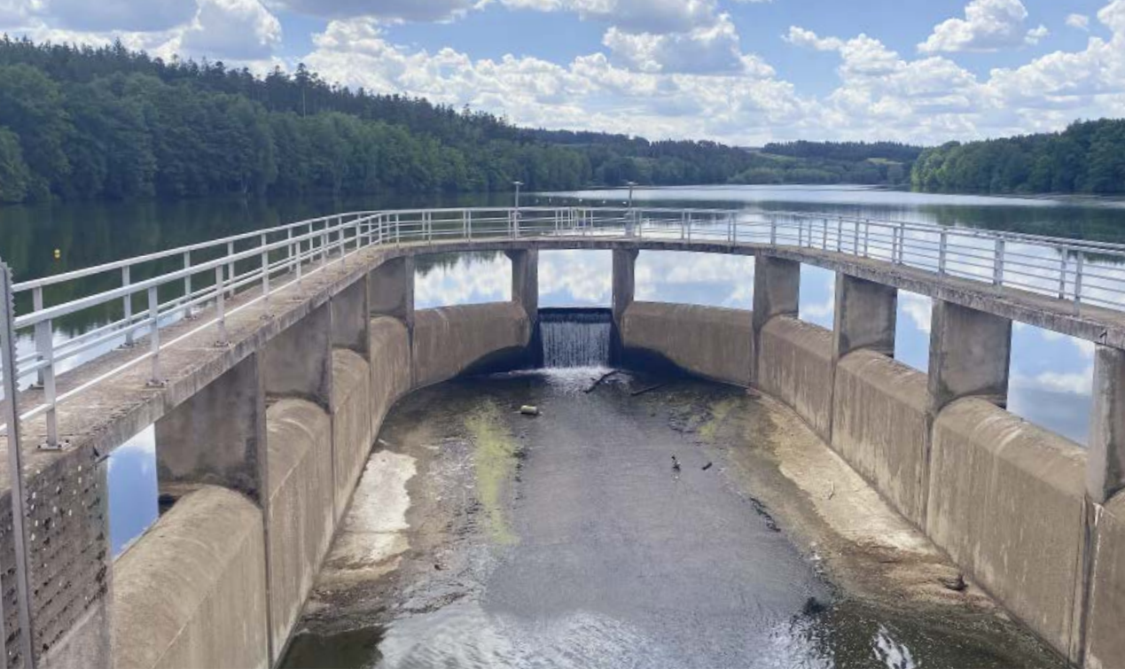
Das Komplexbauwerk im ursprünglichen Zustand bei eingestauter Vorsperre
