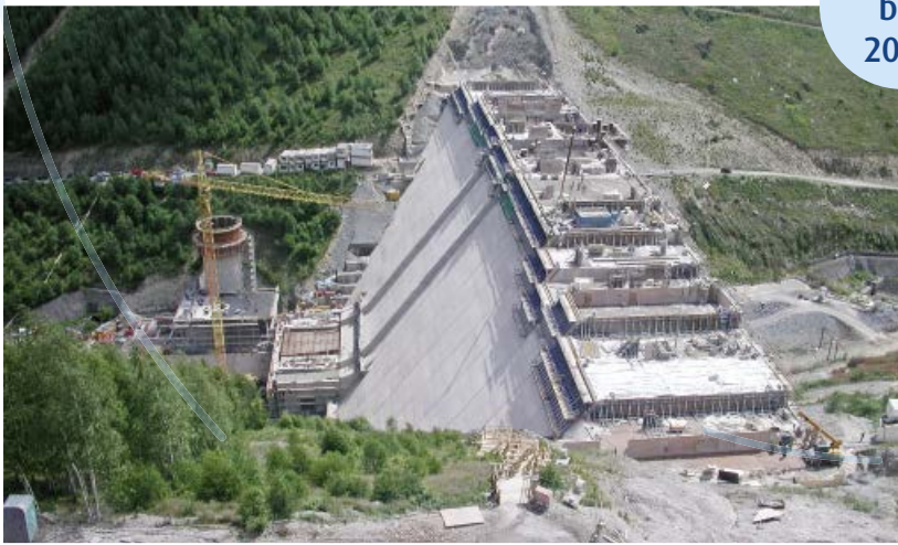
Bau der Talsperre Leibis/Lichte
