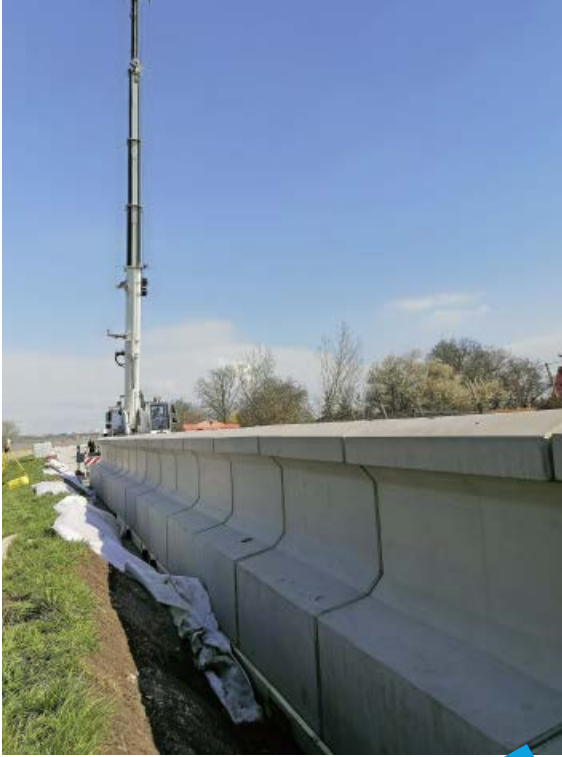
Gesetzte Wellenumlenker am Schutzdamm Henschleben
