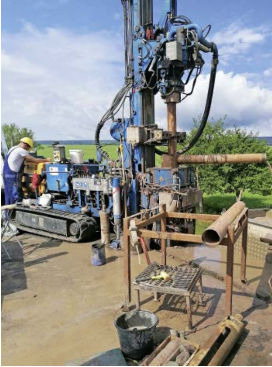
Mit schwerem Gerät werden Bohrkern aus den Staudämmen gezogen
