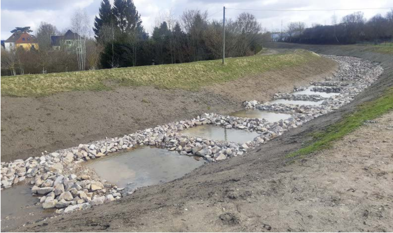
Neuer Gewässerlauf Meerchen – fertiggestellt
