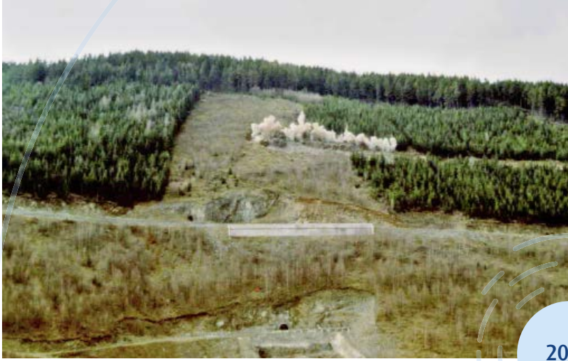
Sprengung im Felsen für das Plateau des Kabelkrans zum Bau der Talsperre Leibis/Lichte
