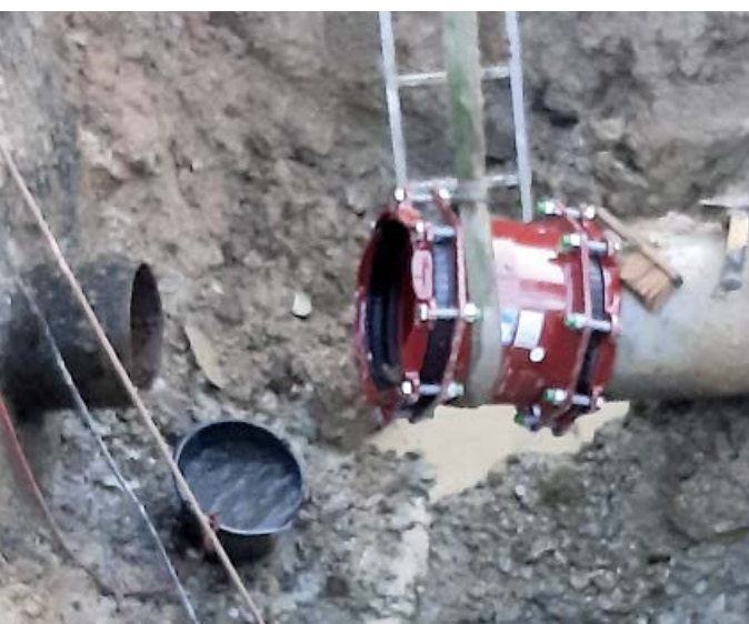
Einfädeln der ersten Schelle nach Entfernung des defekten Rohrstückes
