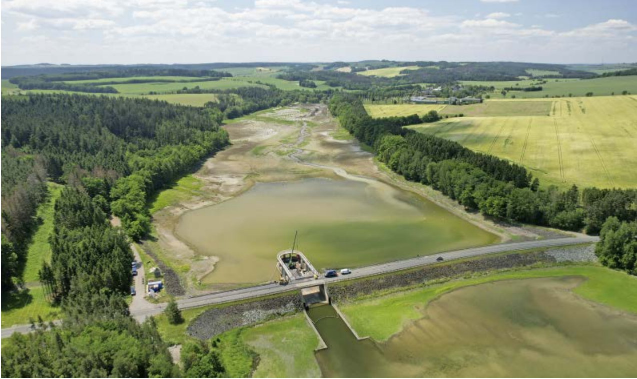
Abgesenkter Stauspiegel in der Vorsperre Riedelmühle
