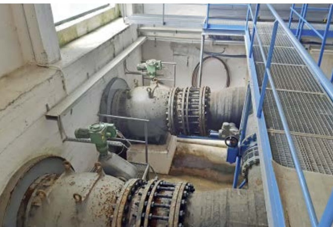
oben: Rohwasserentnahmeleitungen in der Schieberkammer
