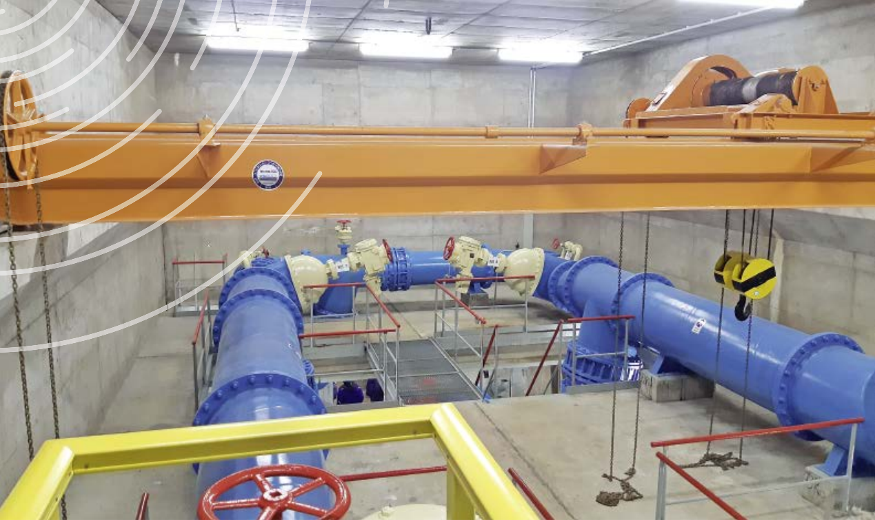
oben: Rohwasserentnahmeleitungen in der Schieberkammer
