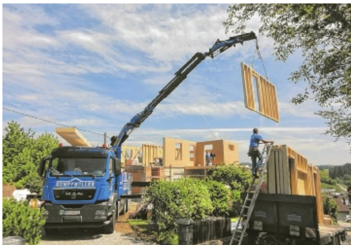
Montage einer Aufstockung in Holzriegelbauweise
