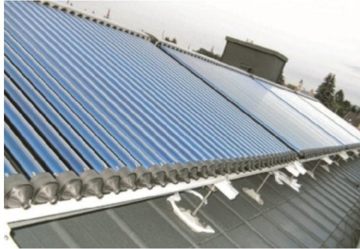
Der Vakuumpöröhrenkollektor ist eine gute Alternative zu den Flachkollektoren.
