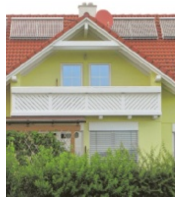
Der Kollektor auf einem Haus
