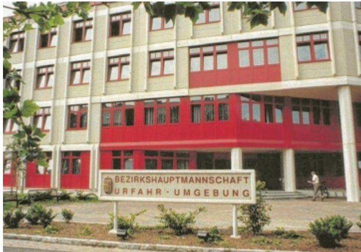
Anlaufstelle: das Gebäude der BH an der Peuerbachstraße 26 in Linz Fotos: Privat
