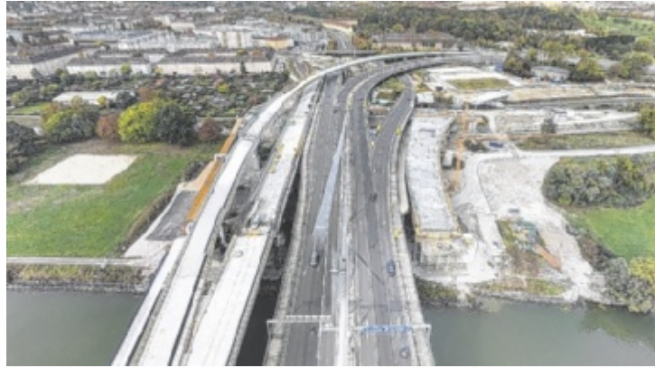
Der Knoten Urfahr – Bild aus der Asfinag-Baustellenkamera
