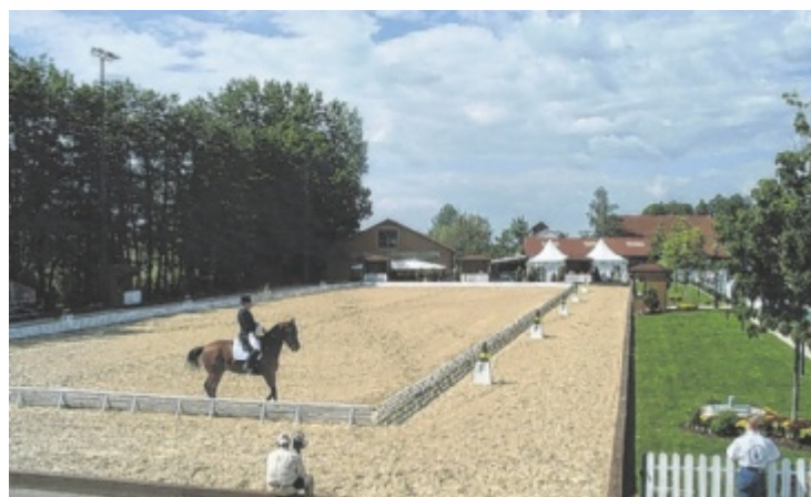
Die Reitanlage Bartlgut in Neuhofen ist mit dem TTE-Bodensystem ausgestattet.
