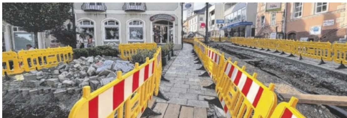
Die Baustellensituation in der Innenstadt stellt die dortigen Geschäfte auf eine schwere Probe.
