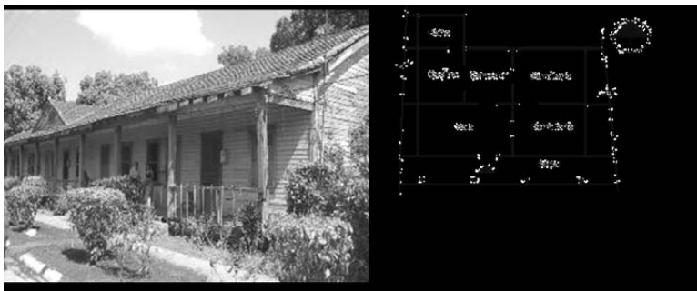
10. Vivienda para obreros, Batey del central azucarero Cándido González, antiguo Santa Martha (Vivienda en Tira).
