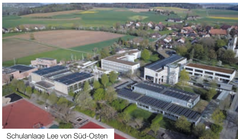
Schulanlage Lee von Süd-Osten
