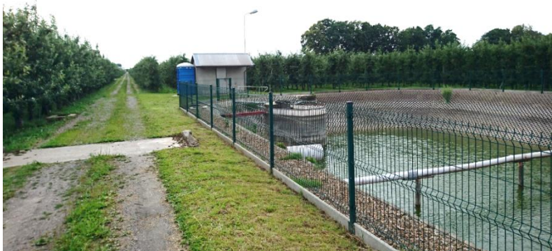
Obr. 12 Nádrž na vodu k protimrazové ochraně. Foto A. Bilavčík.
