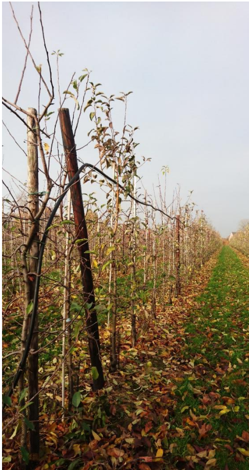
Obr. 13 Instalovaná protimrazová závlaha se směrovými tryskami. Foto A. Bilavčík.
