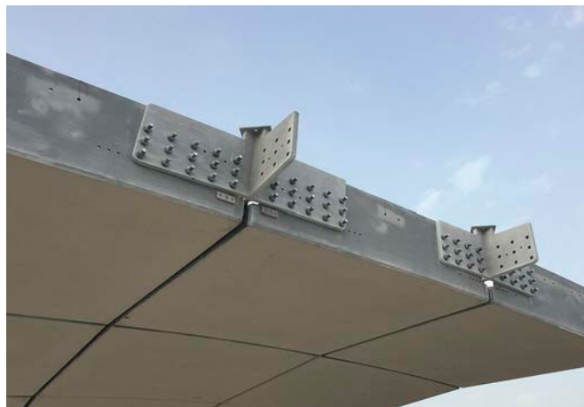
Bild 12 Erster Aufbau eines Schalensegments in Kuwait (September 2018) First mock-up of a shell segment in Kuwait (September 2018)
