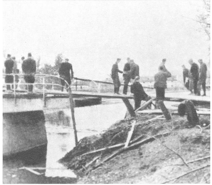
Инжињерци 1. пролетерске бригаде оспособљавају мост на реци Вуки, у Вуковару, 12. априла 1945 (из књиге „Прва пролетерска од Београда до Загреба“)
