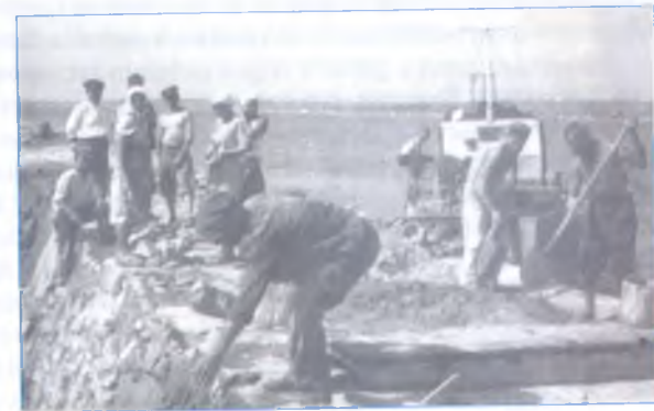
Ремонт волнолома в послевоенные годы.
